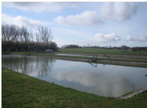
Billede 1 – Infiltrationsbassin, Arrenæs
