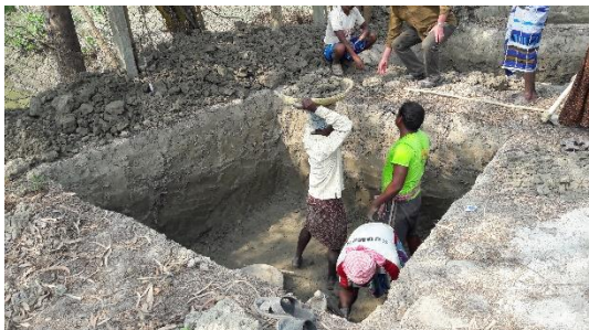
Et par billeder fra udgravning af fundamentet til skolehjem
