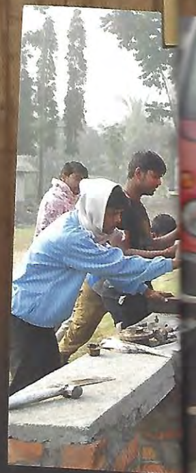
Undervisning i korrekt el-installation.
